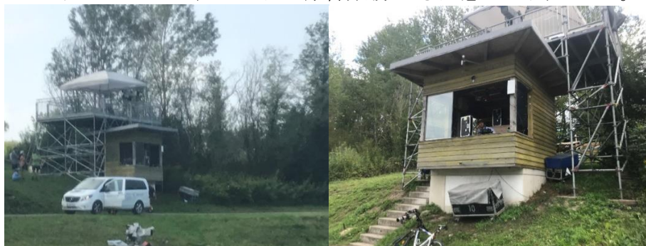
(写真左) 線審小屋 (遠景) (写真右) 線審小屋 (近景)
