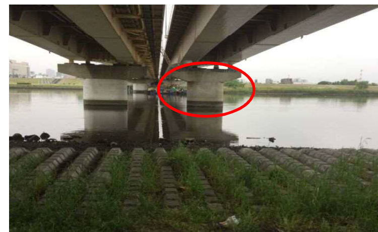
右岸側より撮影
