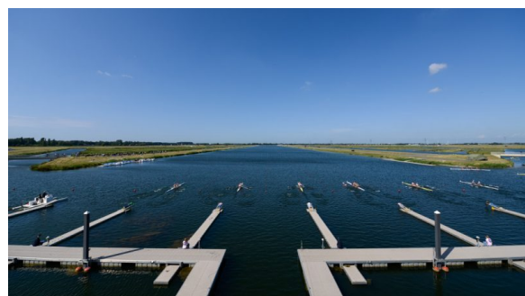
図-5 発艇塔からコース全景
