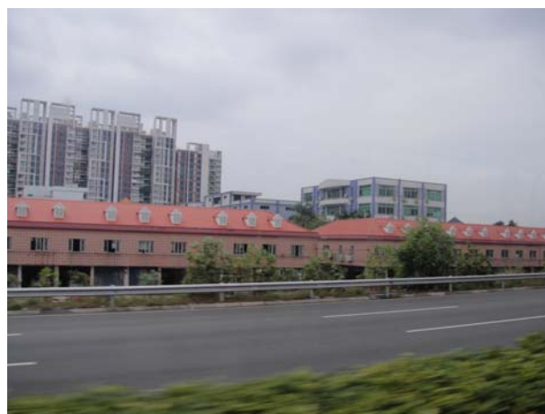
写真-10 空港から市内への高速道路沿線 このような屋根が延々と並ぶ
